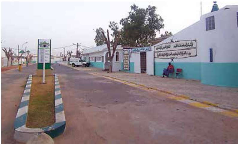
Le complexe Culturel de Hizbut-tarqiyyah à Touba sur la route de Bebel : un cadre d'éducation et de formation culturelle et religieuse (photos d'archives).
